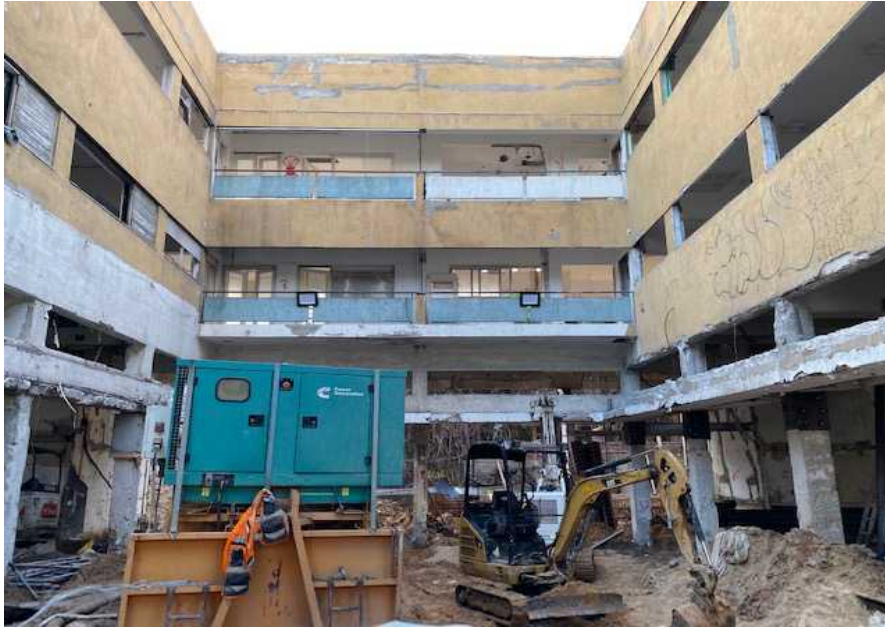
Eine Baustelle in Tel Aviv (Bild: KHC)
