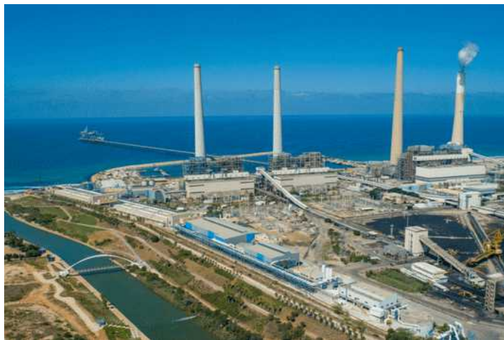
Eine IDE-Entsalzungsanlage in der israelischen Industriestadt Hadera (Bild: IDE Webseite).
