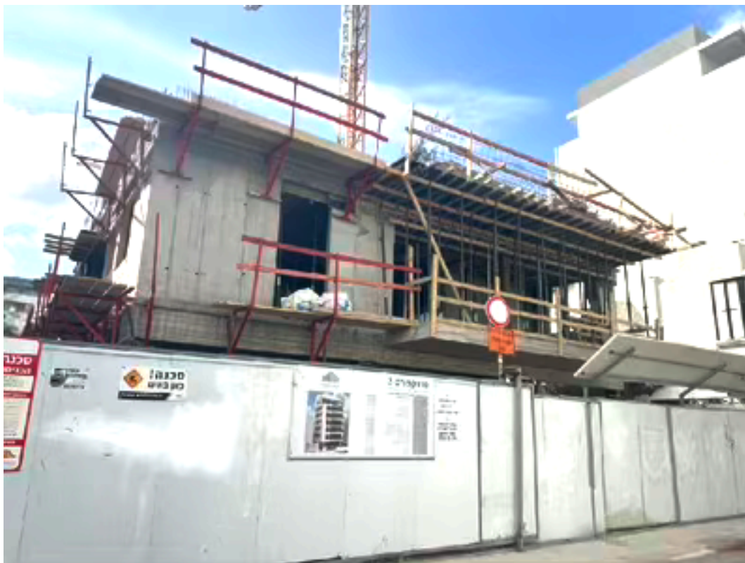
An jeder Ecke eine Baustelle: Besonders hier arbeiten viele ausländische Kräfte (Bild: KHC).
